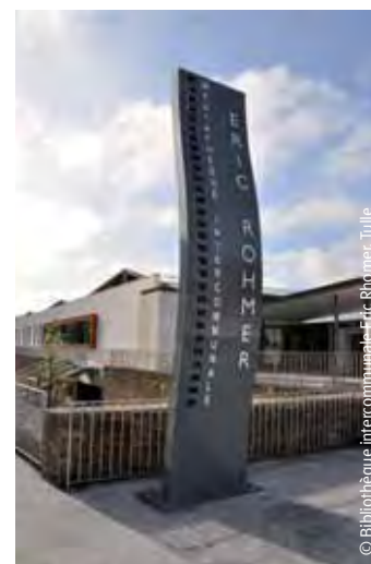
La médiathèque intercommunale Éric-Rohmer, Tulle.
