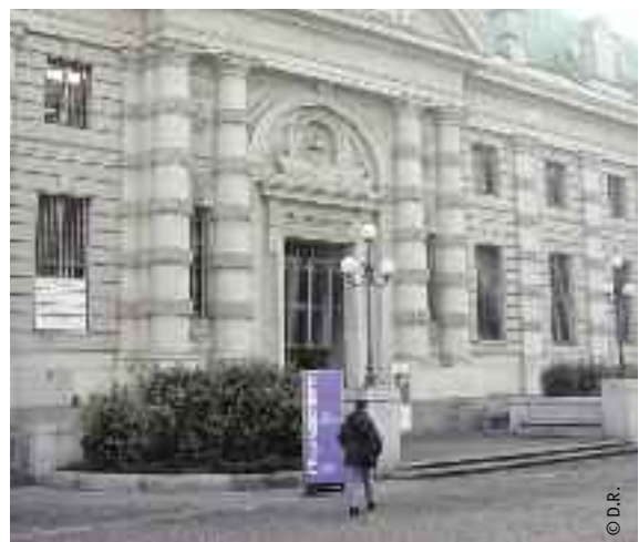
Façade de la BNU.
