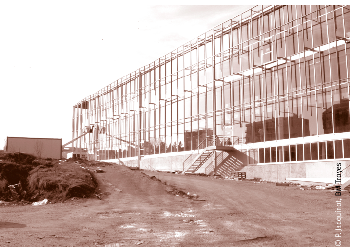
BMVR de Troyes – Façade Est.
