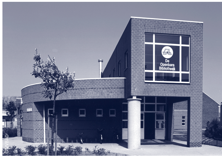
Bibliothèque de la commune d'Aartselaar (Province d'Anvers), construite en 1994.
