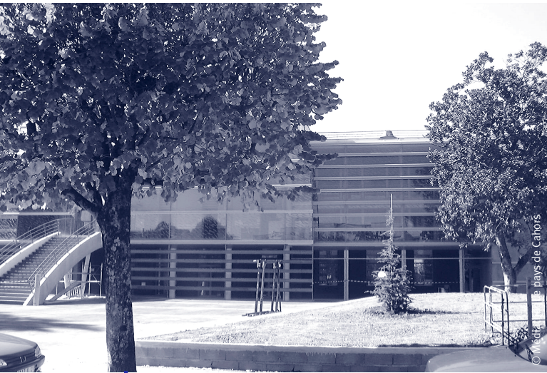
L'architecte de la médiathèque du pays de Cahors est le Bordelais Éric Raffy .
