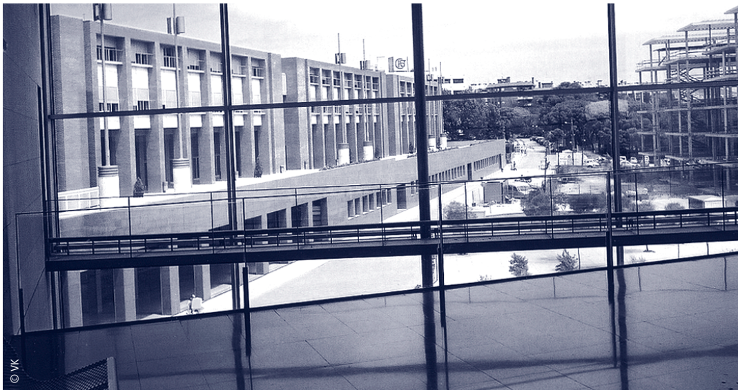
Vue de la bibliothèque de l'école des ingénieurs sur un campus en cours d'agrandissement.
