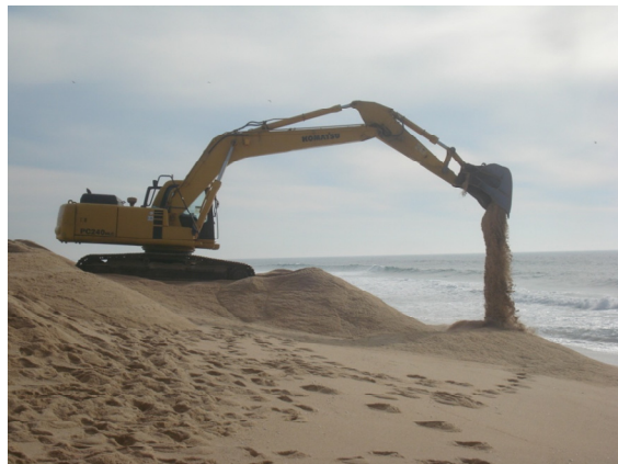
Figura 8: Operação de abertura artificial da barra de maré da Lagoa de Santo André em Março de 2009, com o auxílio de diversos meios mecânicos (Fotos de C. Freitas).
