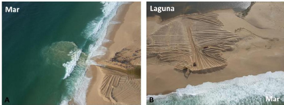
Figura 10: A – Saída do forte fluxo de escoamento das águas aprisionadas imediatamente após a abertura do dique, transportando grande quantidade de sedimentos e nutrientes; B – Operação de abertura artificial da barra de maré no dia 9 de Março de 2009 com o auxílio de meios mecânicos.
