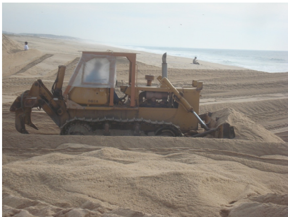
Figura 8: Operação de abertura artificial da barra de maré da Lagoa de Santo André em Março de 2009, com o auxílio de diversos meios mecânicos (Fotos de C. Freitas).
