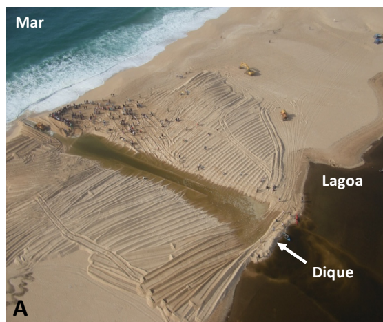
Figura 9: A - Operação de abertura artificial da barra de maré da Lagoa de Santo André, ainda com o dique a estagnar as águas aprisionadas no interior da laguna (Foto de J. Boieiro); B – Rompimento do dique, possibilitando a libertação das águas do interior da laguna.
