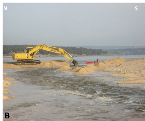
Figura 9: A - Operação de abertura artificial da barra de maré da Lagoa de Santo André, ainda com o dique a estagnar as águas aprisionadas no interior da laguna (Foto de J. Boieiro); B – Rompimento do dique, possibilitando a libertação das águas do interior da laguna.
