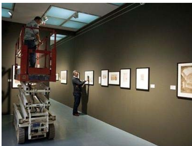
Luminotécnico a orientar as luminárias, em função das peças expostas 511
