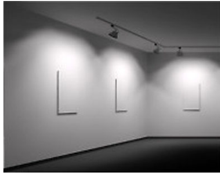
Floodlights instalados num sistema de calhas
