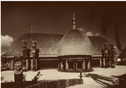
Fig. 49- Pavilhão de Angola e Moçambique
