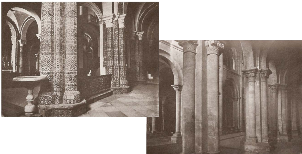
Figuras 16 e 17 – Nave da Sé Velha de Coimbra antes e depois da intervenção 63 .
