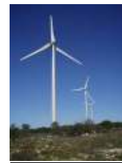
FIGURA B-16 – Parque Eólico da Videira, com 3 aerogeradores.
