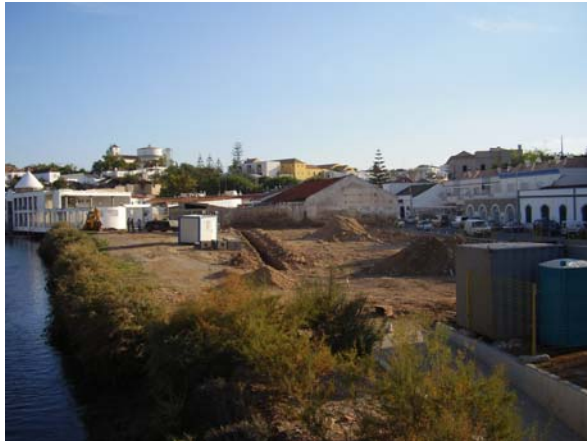
Figura 58 – Futuro Parque de Estacionamento junto à Estação Rodoviária Fonte: Autora
