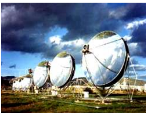
Figura N° 2.17. SES I y II. Mojave. EEUU
