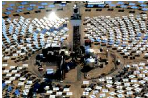
Figura N° 2.26. Solar one, California
