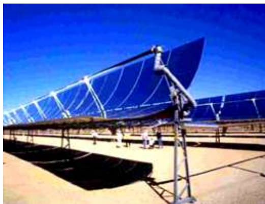
Figura N° 2.4. Planta SEGS 354 MW, California
