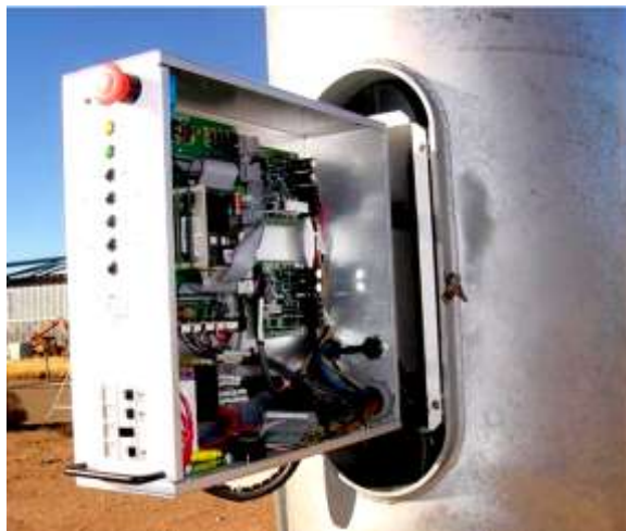
Figura N° 3.24. Sistema de control
