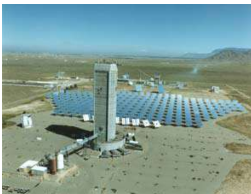
Figura N° 2.27. Campo NSTTF, Nuevo México
