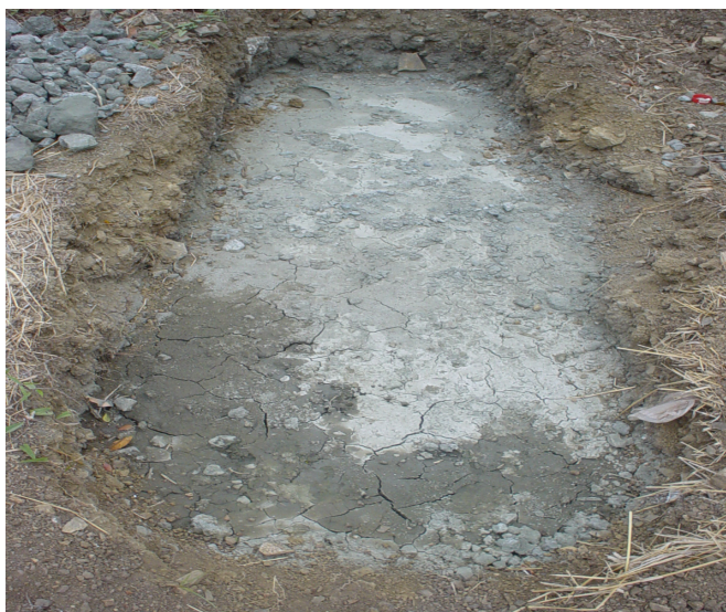
Foto 5.34.- Comprobación visual del estado del suelo contaminado en el segundo mes de tratamiento.
