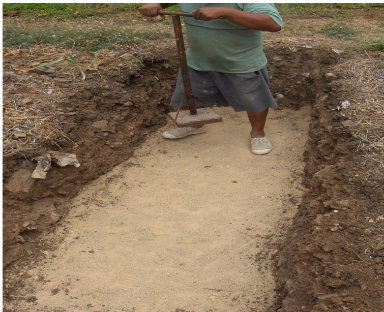
Foto 5.2.- Compactación de la arcilla.
