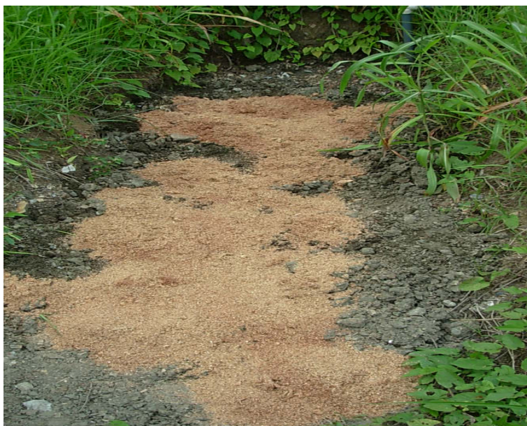
Foto 5.22.- Colocación de aserrín en la celda de remediación.
