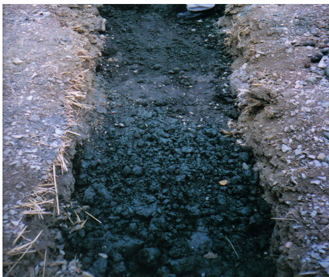
Foto 5.33.- Material contaminado con gasolina en la primeras etapas del proceso de remediación.
