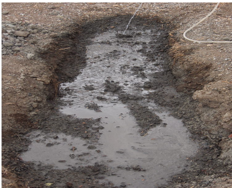
Foto 5.11.- Adicción de agua al material contaminado
