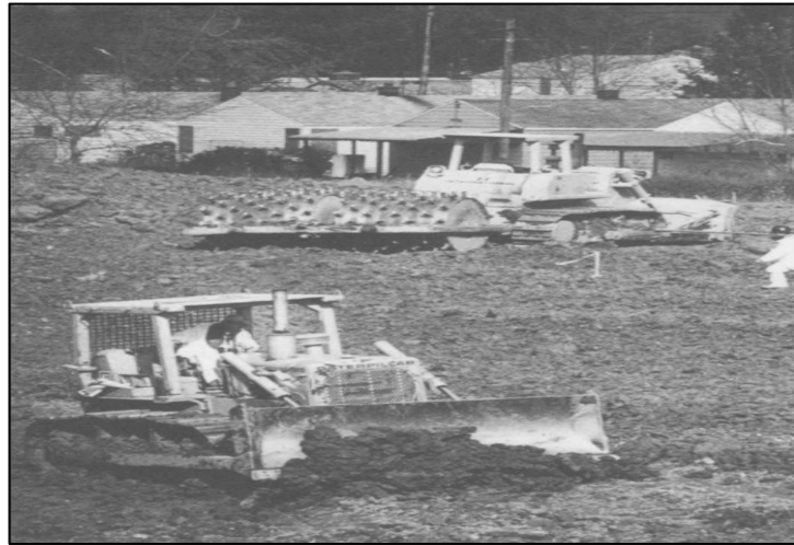
Figura 1.7.- Movimiento de tierra en Times Beach, Missouri después de detectar la presencia de Dioxina en el suelo. ( The Washington Post )
