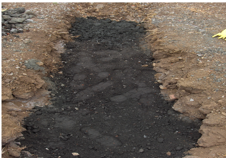
Foto 5.9.- Colocación del material en las celdas de remediación
