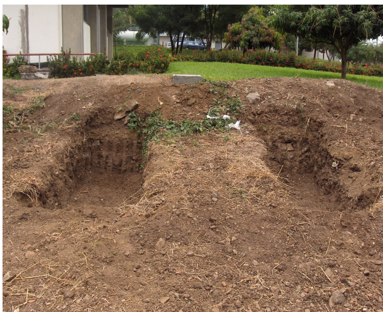
Foto 5.1.- Apertura de las zanjas
