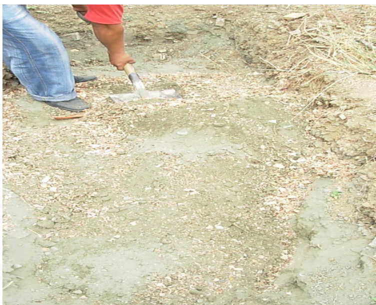
Foto 5.13.- Adición de aserrín al material.
