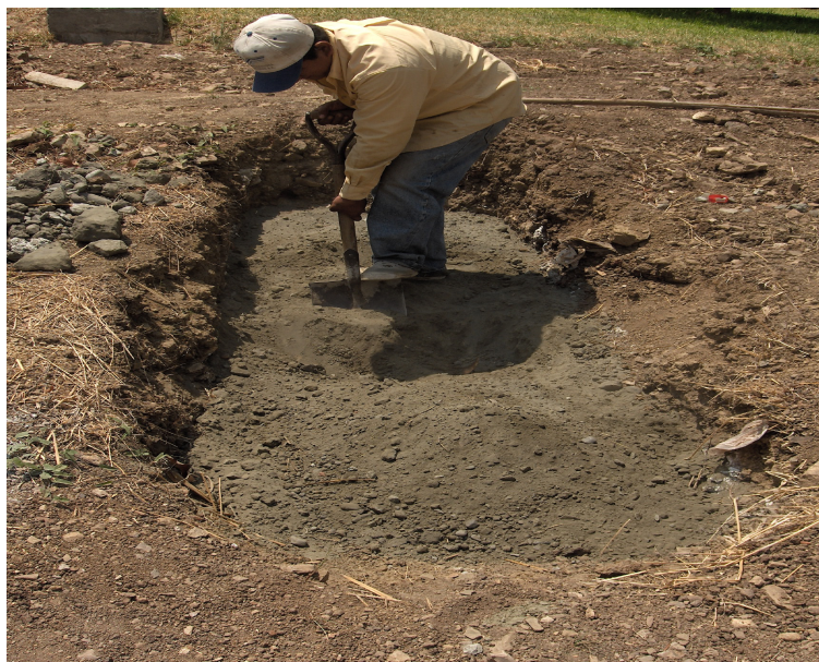
Foto 5.12.- Mezcla y movimiento del suelo
