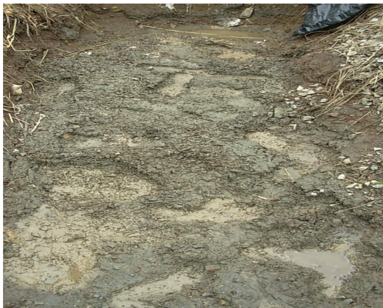
Foto 5.19.- Extracción del agua de las celdas
