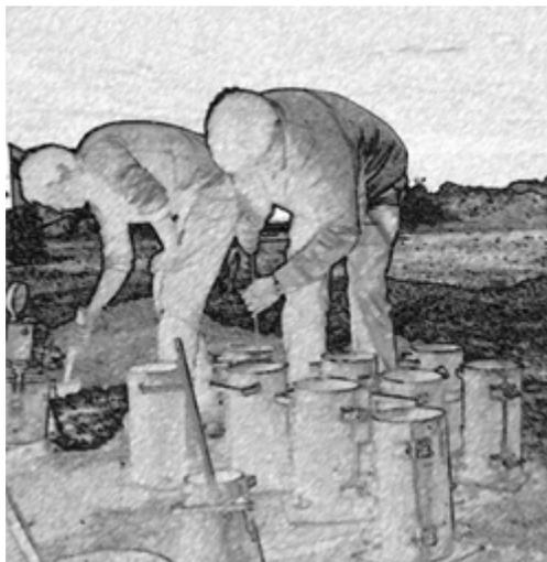
Figura 1: Llenado del Cono de Abrams. <sup>(12)</sup>
