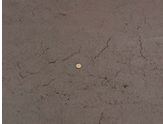
Fotografía 4. Fisuración superficial
