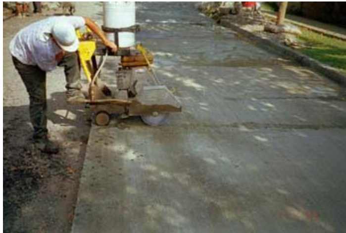
Fotografía 9. Aserramiento mecánico de una junta de contracción.
