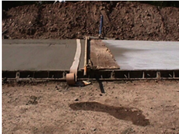
Fotografía 11. Curado con membrana.
