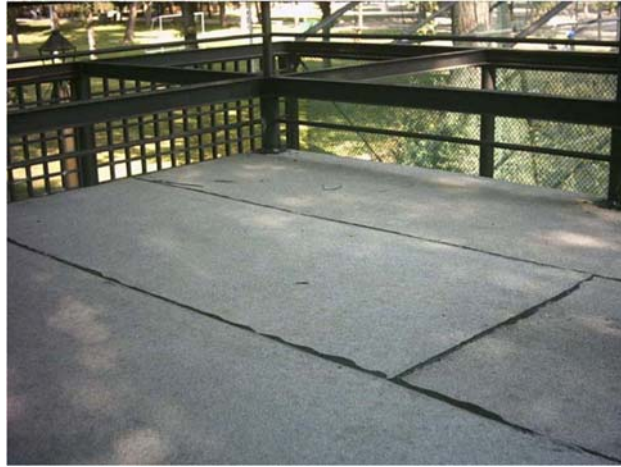
Fotografía 14. Membrana de Impermeabilización.
