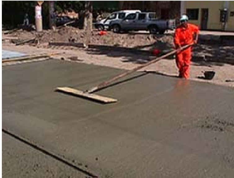
Fotografía 13. Acabado superficial de un pavimento de hormigón.
