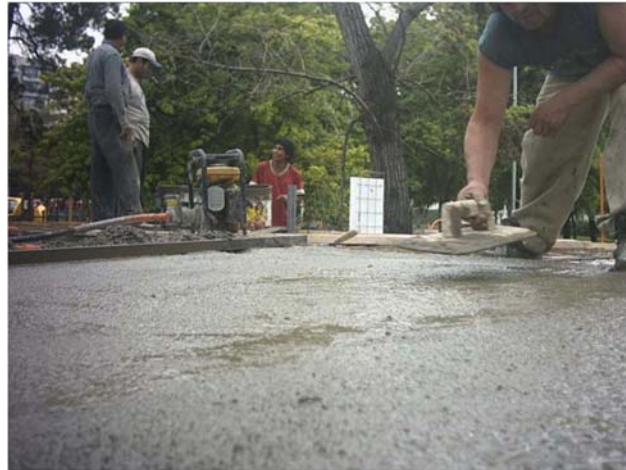
Fotografía 12. Fratasado de losa de hormigón.
