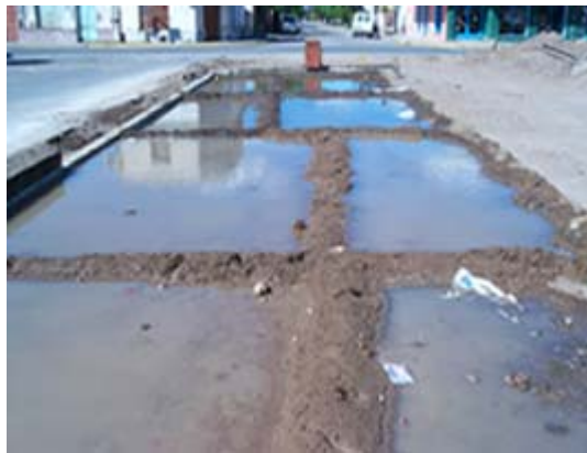
Fotografía 10. Losa inundada para curado
