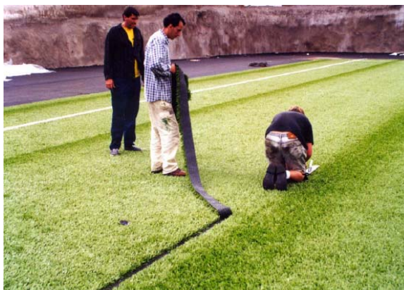
Colocación de líneas y arcos
