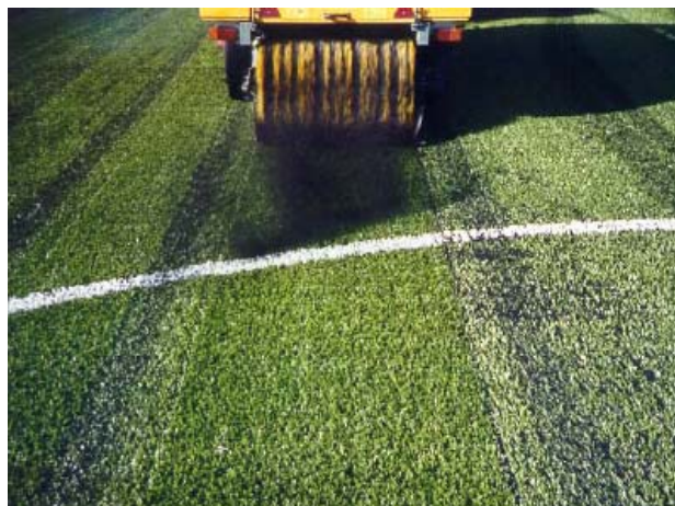
Figura No 4.10 Cepillado y fibrilación
