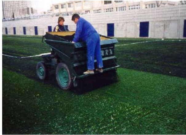
Figura No 4.9 Riego de arena y caucho
