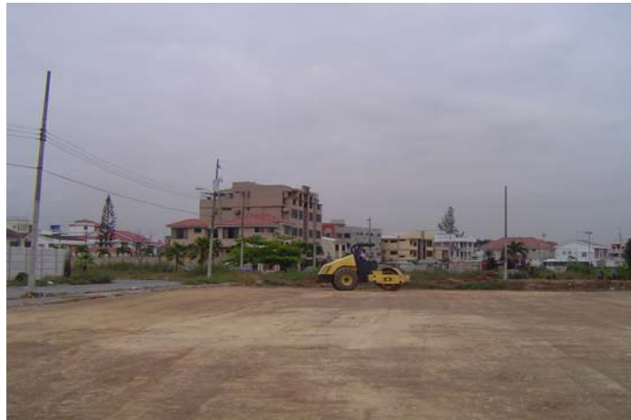
Figura No 4.3 Compactado y Nivelación
