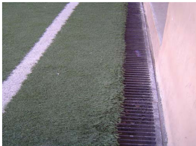
Figura No 4.4 Canales de Drenaje
