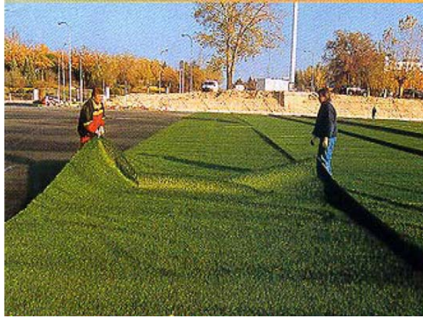
Figura No 4.6 Tendido de los Rollos
