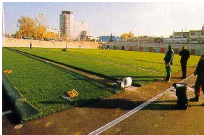
Figura No 4.7 Unión de Rollos
