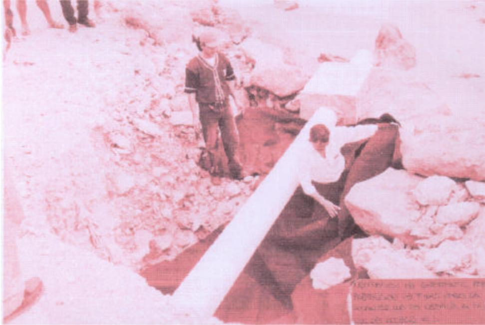
Foto 3: Recubrimiento de la tubería de AA.SS con geotextil, previo a la construcción de las escolleras
