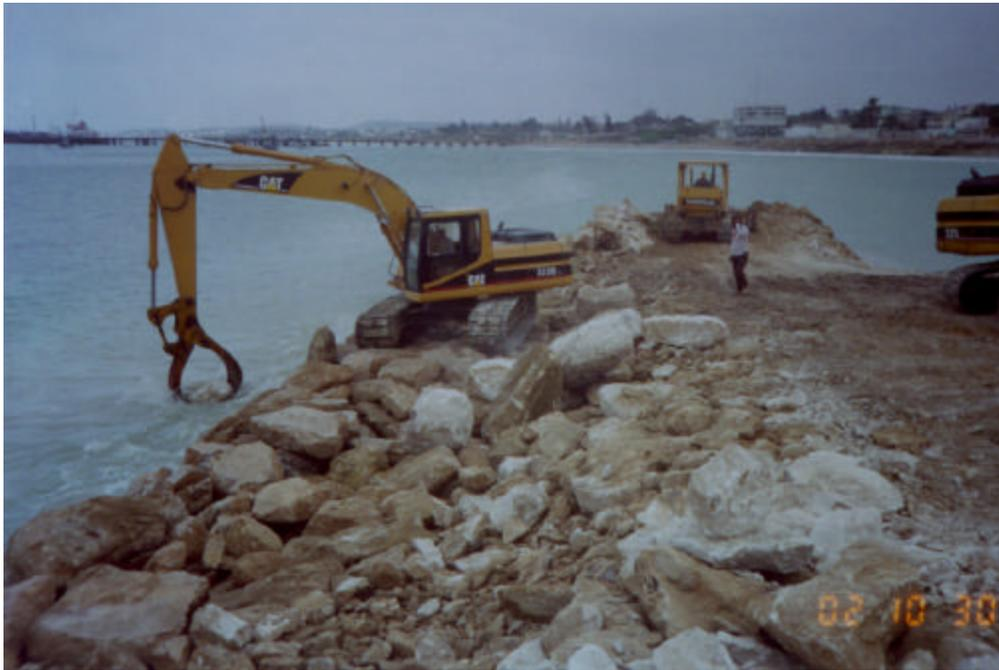
Foto 9: Colocación de la berma en el talud exterior de las escolleras costa-afuera
