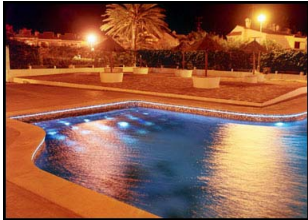
Figura 2.38. Iluminación ornamental con fibra óptica plástica.
