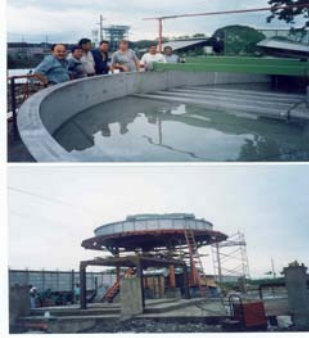
Fig # 44: Proceso de Montaje del Clarificador
