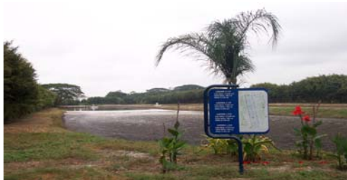
Fig # 18 "Ingreso a las Lagunas de Retención de PANASA"
