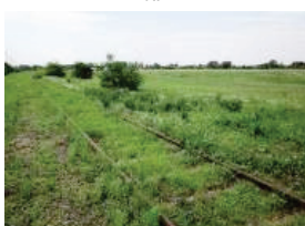
11. Nagy-Burma vasút Szemere telep megalóhely után
