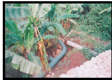
Gambar 4.12. Pipa Transmisi dari Turbin Pompa ke RB-2 Di Kaligoro Sumber : Dokumen Pribadi, 2008
