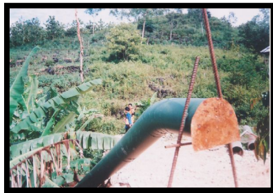
Gambar 4.12. Pipa Transmisi dari Turbin Pompa ke RB-2 Di Kaligoro Sumber : Dokumen Pribadi, 2008
