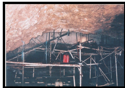
Gambar 4.6. Perancah Perletakan Barrage dan Turbin Pompa Sumber : Dokumen KKL, 2006
