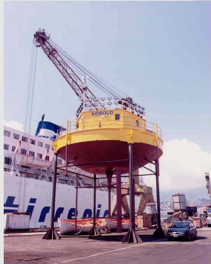
60 kW Pilot system 6 m Durchmesser, 5 m hoch
