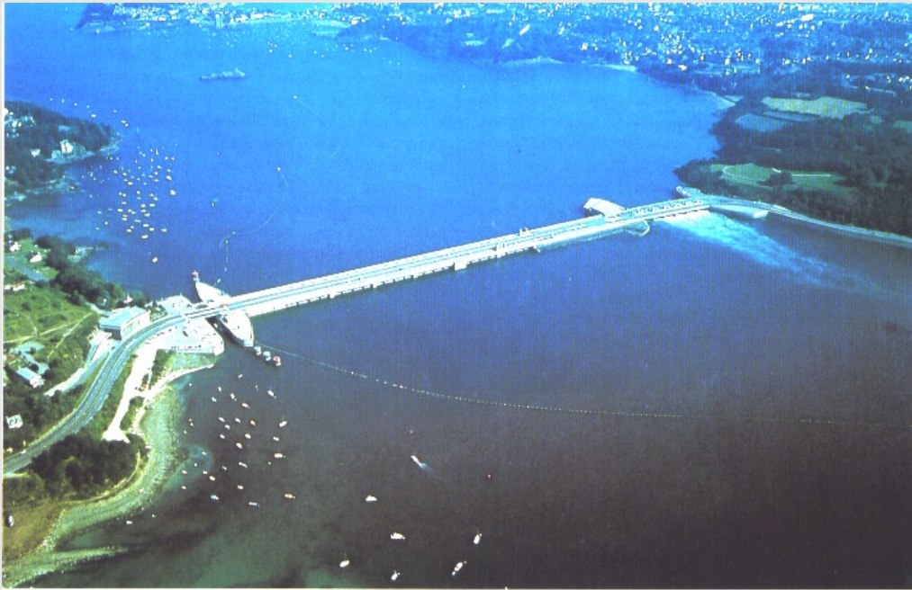
St. Malo, 240 MW erbaut 1966
