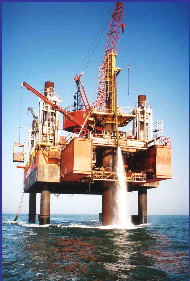
Bohrung für die Fundamentierung des Turmes
