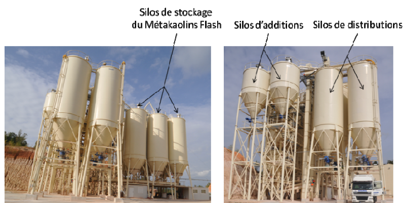
Figure III.6 : Silos d'expédition (4) et silos de stockage (6) à gauche, 4 petits silos d'additions et silos d'expédition à droite
