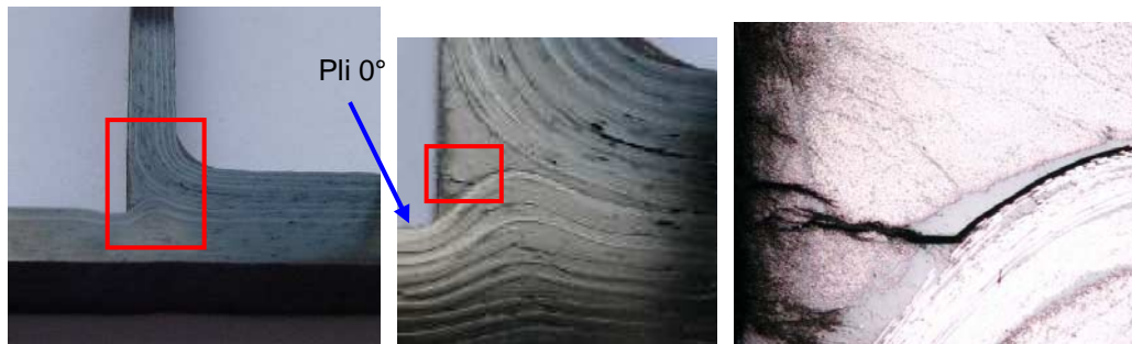
Figure IV-9 : Détail de l'ondulation des plis de la peau et de la fissure à l'interface peau/pied de nervure
