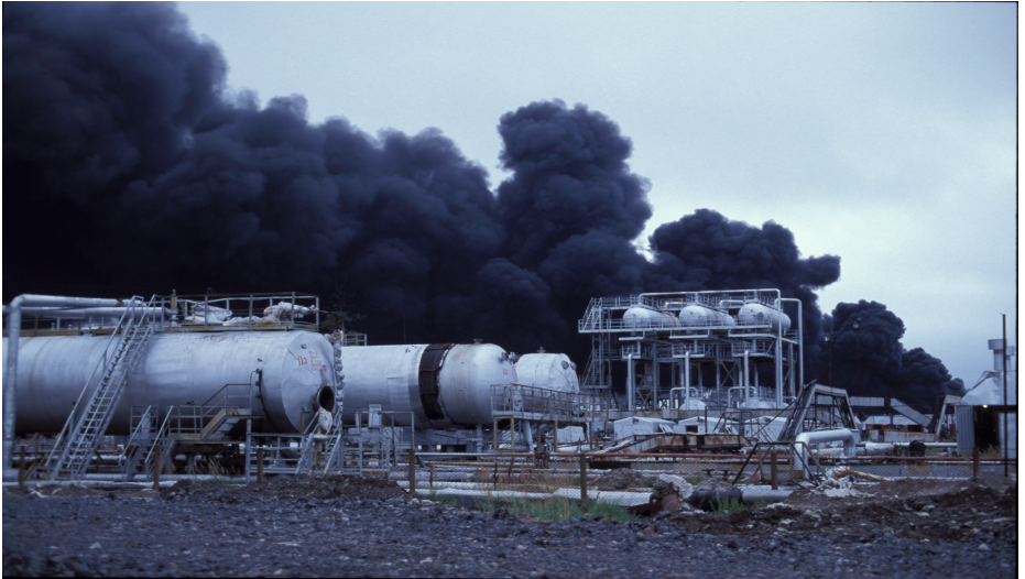
Abb. 13: Havarie auf einer Ölförderstätte auf dem ehemaligen Wohngebiet der Sopotchiny.
