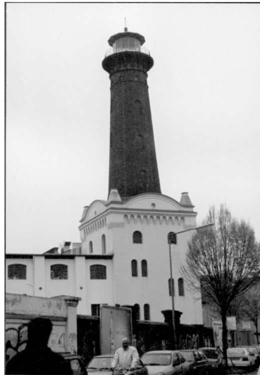
Industriegeschichtliches Relikt – Leuchtturm in Ehrenfeld
