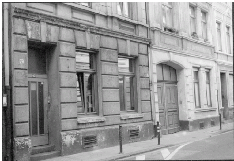
Weiterhin im Viertel zu finden – günstiger, sanierungsbedürftiger Wohnraum
