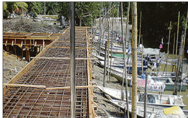
Rajah 3: Jeti yang rosak akibat tsunami tahun 2004 sedang dinaiktaraf (Noh, 2011b)
