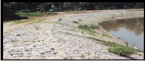
Rajah 2 : Lapis lindung Gabion Mattress
