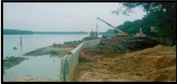
Rajah 13: kerja-kerja pembinaan struktur berbentuk L
