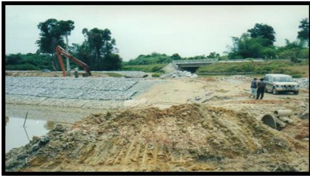
Rajah 9: Kerja pembinaan struktur kawalan hakisan dan banjir
