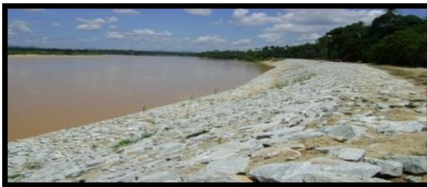
Rajah 7 : Kaedah struktur Rock Revetment
