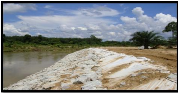
Rajah 6: Semasa pembinaan struktur hakisan dan banjir
