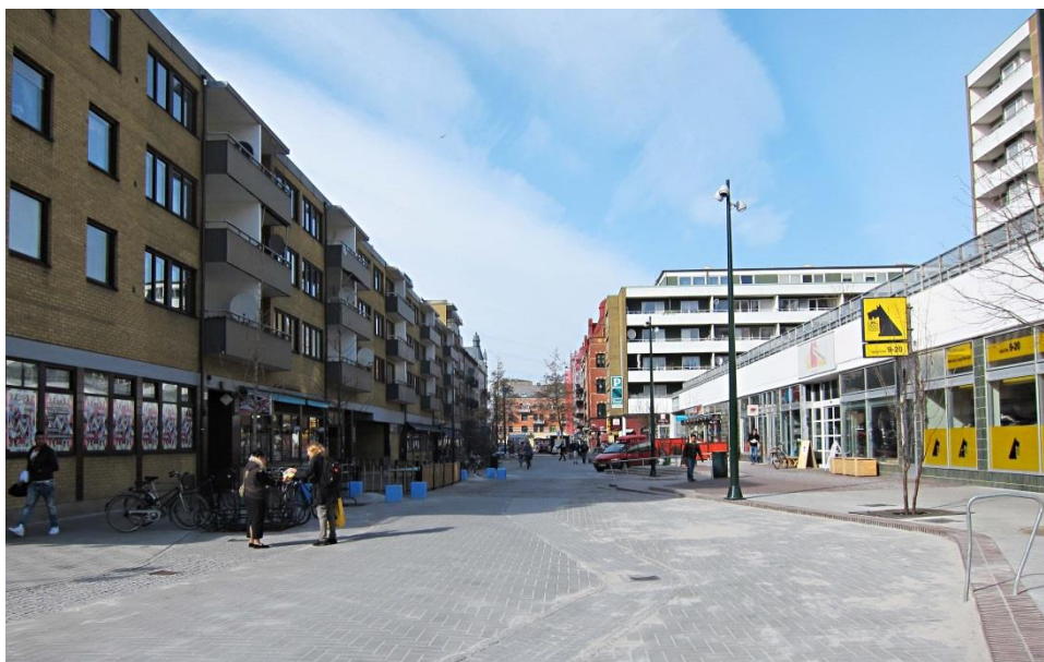
Claesgatan Malmö. De gående har fått en större plats i gaturummet efter omdaning av gatan. Foto: Ulrika Bergbrant 2013
