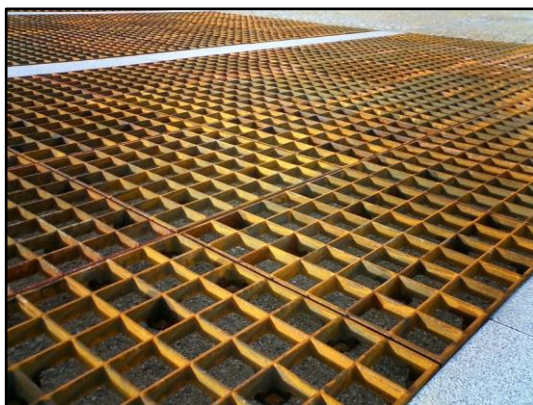
Figur 16: Fotografi föreställande förstärkningsgaller Cast Iron Græsarmering ( GH form u.å.).
