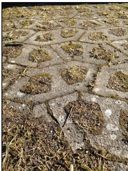
Figur 32: Fotografi föreställande beläggningsyta av hålstenar fyllda med jord och skadat vegetationsmaterial (Annika Ritzman 2013).
