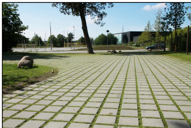
Figur 21: Fotografi föreställande beläggningsyta av Siena 10 cm 233 Eco med fogar fyllda av gräs (Starka u.å.).
