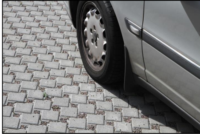
Figur 19: Fotografi föreställande beläggning av Uni-Ecoloc ® med fogar fyllda med grovkornigt material (Starka u.å.).
