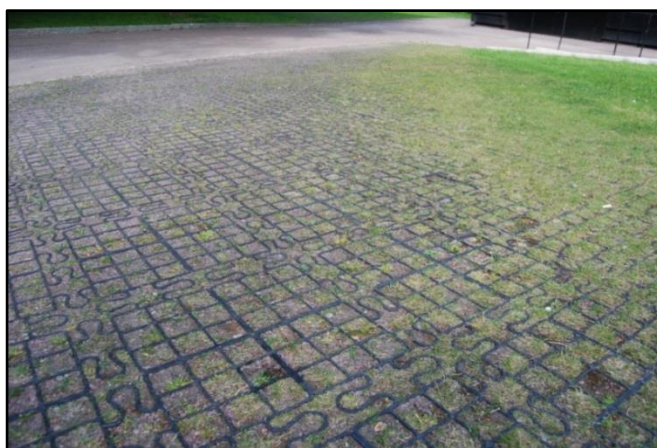
Figur 15: Fotografi föreställande gräsyta med förstärkningsnät (Agnes Kristiansson 2011).
