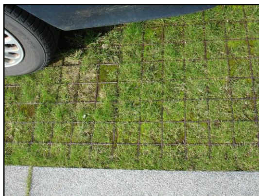
Figur 17: Fotografi föreställande gräsyta förstärkt av Cast Iron Græsarmering ( GH form u.å.).
