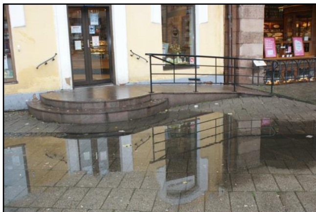
Figur 24: Fotografi föreställande vattenansamling på markbeläggning med tätt lagda enheter (Angelica Nilsson 2011).
