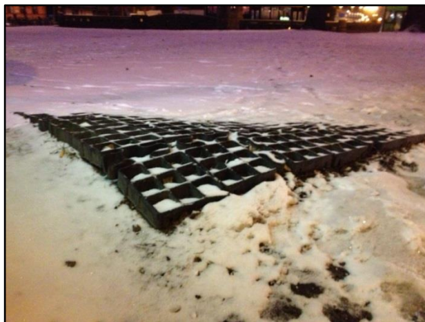
Figur 9: Fotografi föreställande förstärkningsnät av plast som tryckts upp ur lagret av jord- och vegetationsfyllning (Annika Ritzman 2013).
