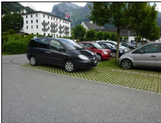
Figur 31: Fotografi föreställande parkeringsyta belagd med gräsarmering (Brita Svensson 2011).
