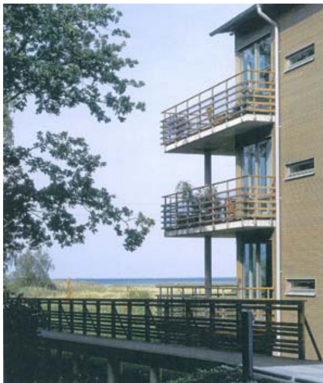
Flerbostadshus i trä smälter in. Det ligger i skogsbrynet med utsikt över vattnet. Opus, Höllviken (Bild 7: Fojab Arkitekter)
