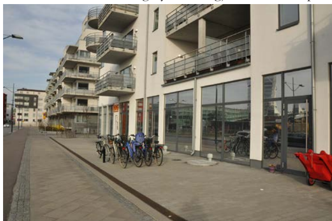
Förgårdsmarken saknar till stor del vegetation och är därtill solbelyst hela dagen. Det gör att lokalklimatet här inte inbjuder till vistelse under varma sommar dagar.
