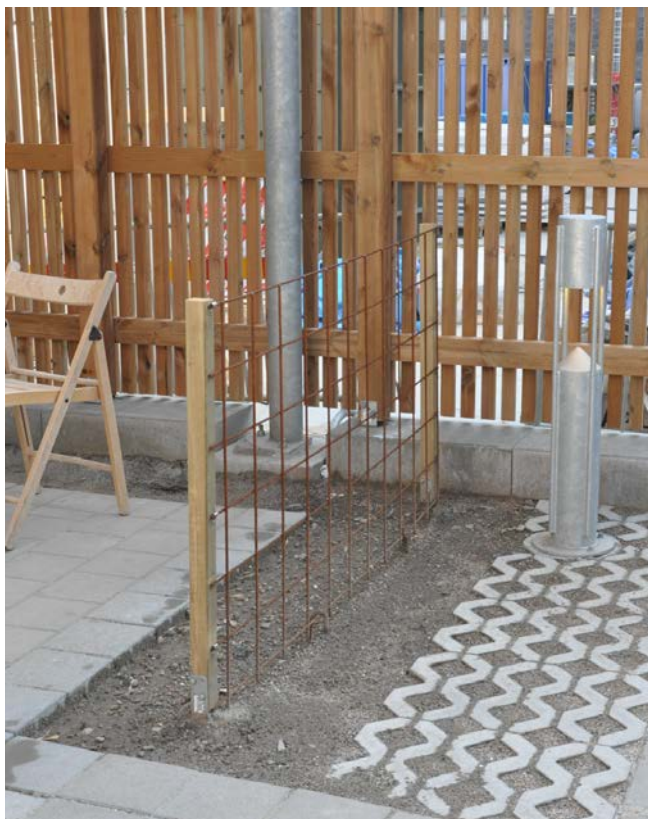
En del lösningar och materialval känns billiga, som den här skärmväggen bestående av ett armeringsnät infäst i smala trästolpar.
