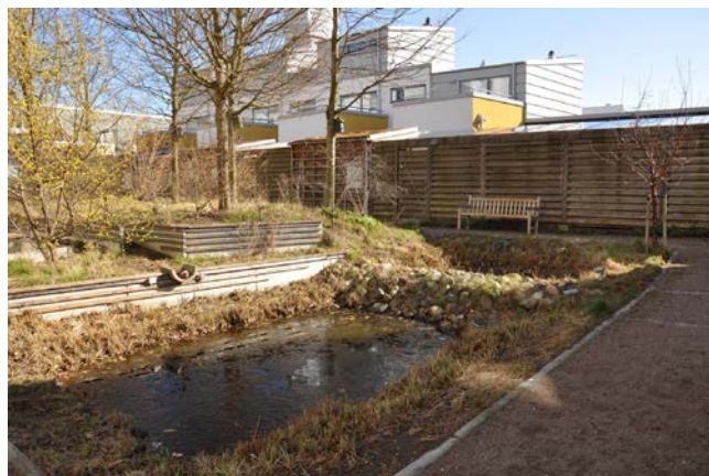
På gården finns en dagvattendamm med stående vatten, vilket hjälper till att jämna ut temperaturen.
