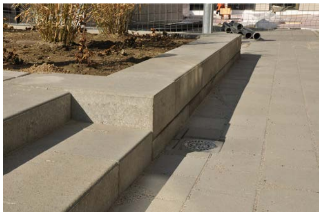
Dagvattnet från de hårdgjorda ytorna leds till brunnar.
