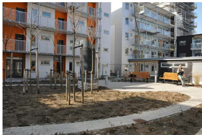
Gården har ett tydligt formspråk där form går före funktion. Stora delar av gården utgörs av planteringsytor som ej går att vistas på.
