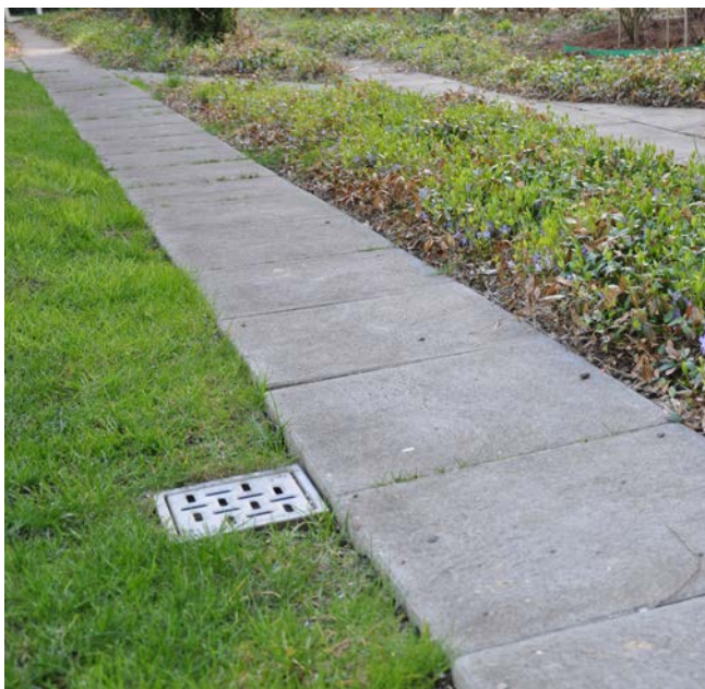
Inget lokalt omhändertagande av dagvatten finns, utan dagvattnet leds istället till brunnar.
