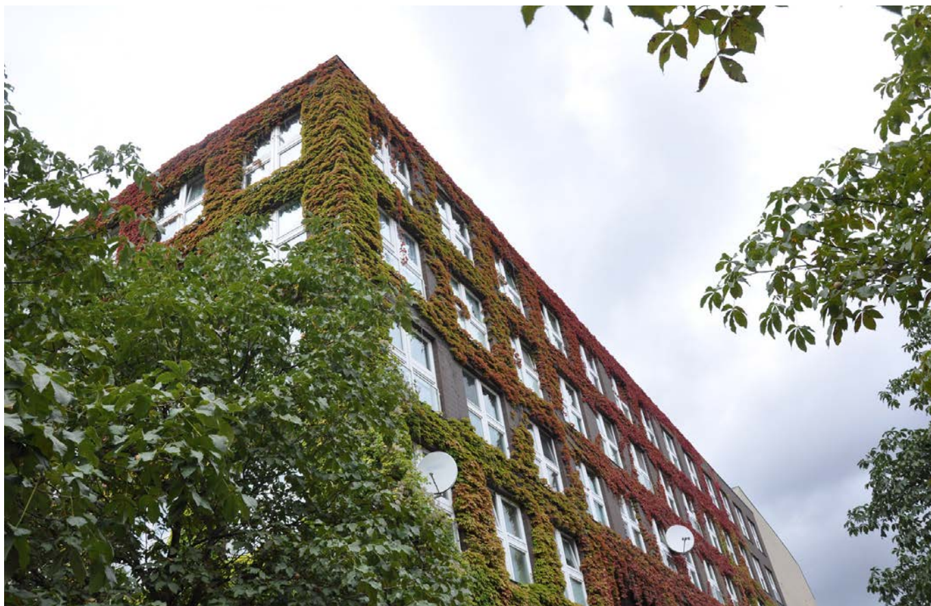
Vegetation längs fasader är ett effektivt sätt att dämpa buller.
