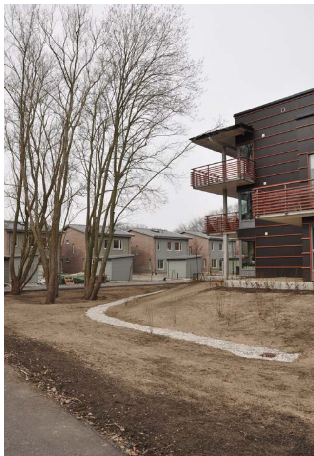
Ett gräsbeklätt svackdike finns i en del av gården, vilket har en kupolbrunn i nedströmsänden.
