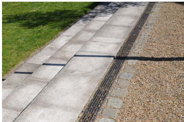
Avvattningen sker till brunnar, som denna grusyta där vattnet leds till en ACO drain-ränna.
