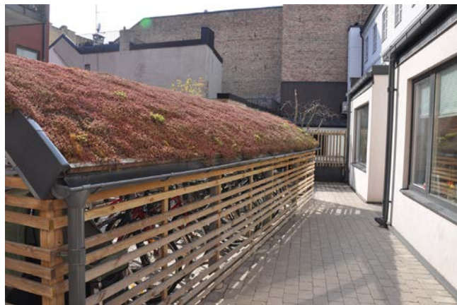
Gröna tak används på cykelbusen och delar av gårdsbuset. Buller hörs från stadslivet utanför och därför skulle det vara fördelaktigt med än mer gröna tak.
