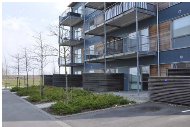
Parkeringsytorna är belagda med asfalt, men det finns även planteringsytorna med buskar och träd.
