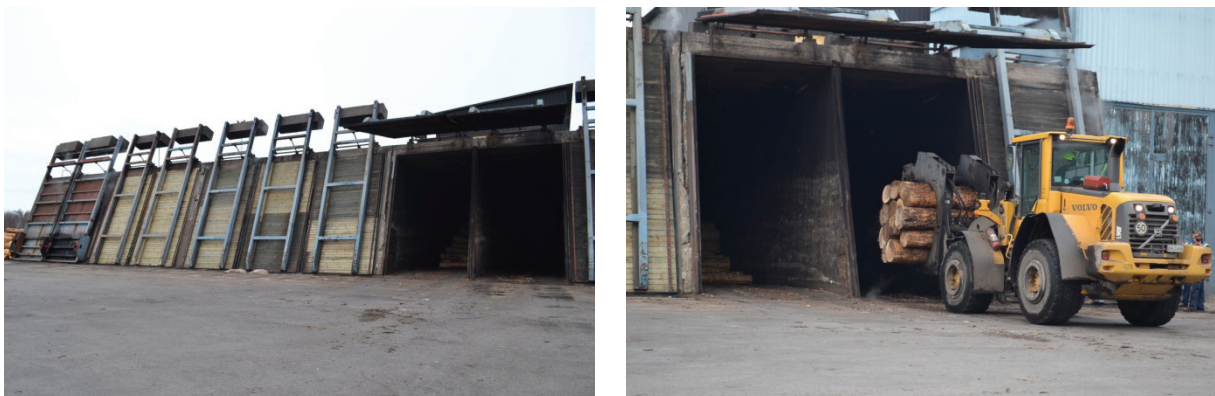
Figur 6. Bilden t.v. visar basningskammarna varav den högra är öppen och lastas ur med hjälp av en hjullastare, bilden t.h.
