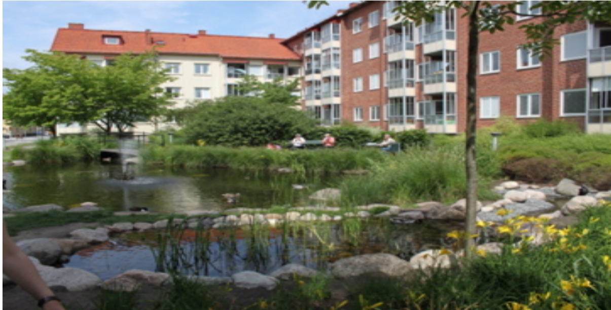
Figur 36, visar öppen damm för rening av dagvatten och rekreation, Augustinborg Malmö (Foto: Kalida Mohammed)
