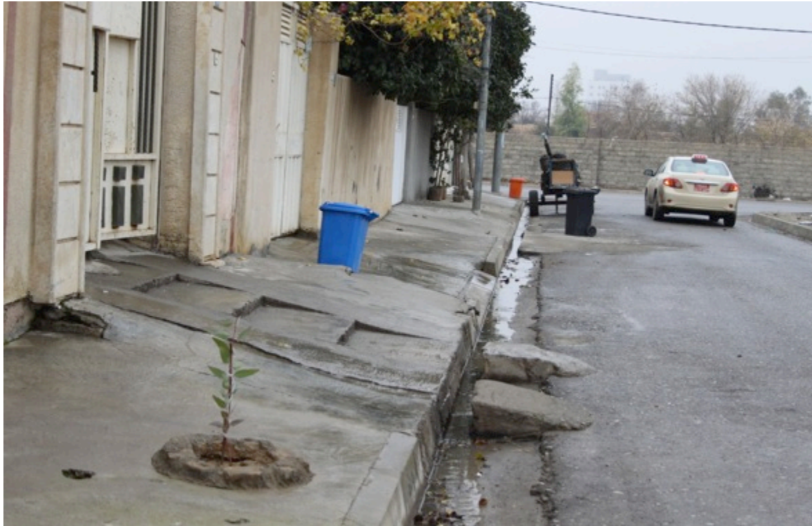
Figur 6. Dagvattenrännor, bild från Hewlêr där dag- och BDT vatten rinner öppet dike. Rinnande vatten från fastighetens tak, garage, bad och kök samt från gatan ska ledas via de här smala kanalerna oavsett väderförhållanden. Den nyplanterade eukalyptusplantan hindras från att ta del av det rinnande vattnet, och är helt beroende av människan för kontinuerlig tillförsel av vatten (Foto: Kalida Mohammed)
