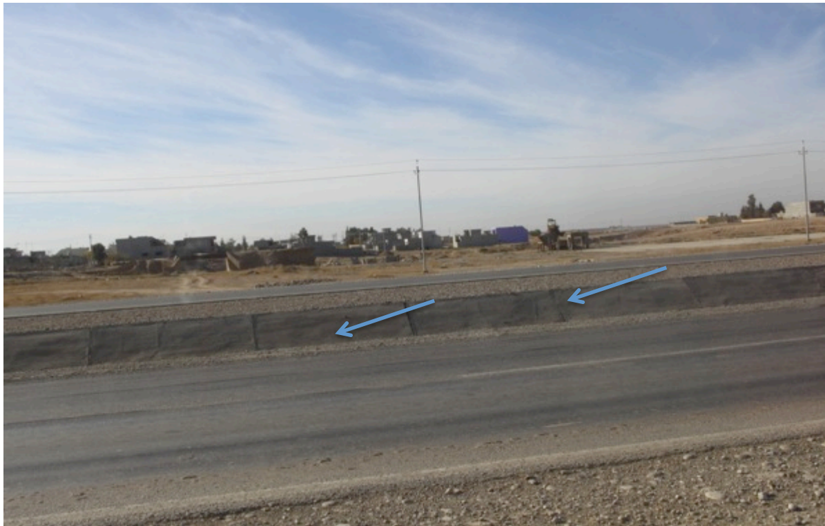
Figur 24, visar en nybyggd transportkanal av dagvatten mellan staden Hewlêr och Pirdê där regnvatten från hårdgjorda ytor och körbanor transporteras ca 40 km mot staden Pirdê. Diket slutar vid en lågt belägen odlingsmark där man i tusentals år använt marken för odling av säd. Transport av dagvatten i långa sträckor orsaker obalanserat vattenförhållande i avrinningsområdet, vilket senare medför bland annat sänkning av grundvatten i marken, snabb torkning av vattenkällor. Dessutom blir markvatten svårtillgängligt för växterna (Foto: Kalida Mohammed)
