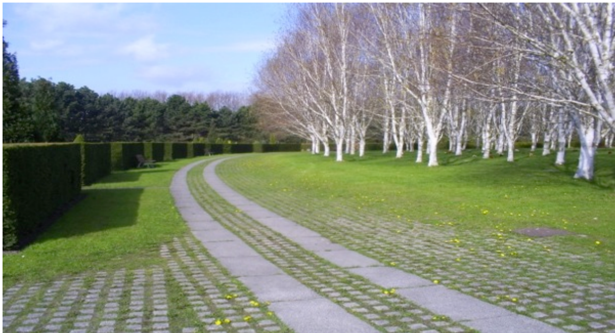
Figur 31, visar ett exempel på Infiltrationsytor, här har gräs och natursten använts för att skapa infiltrationseffekt så att det rinnande vattnet på gångarna lätt kan infiltrera i marken, Danmark (Foto: Kalida Mohammed)
