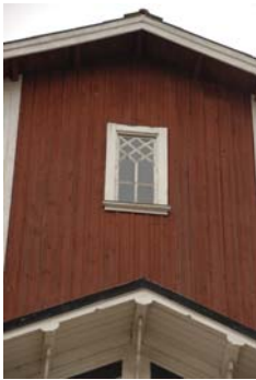
Figur 16. Krysspröjsfönster på elevators gavel.
