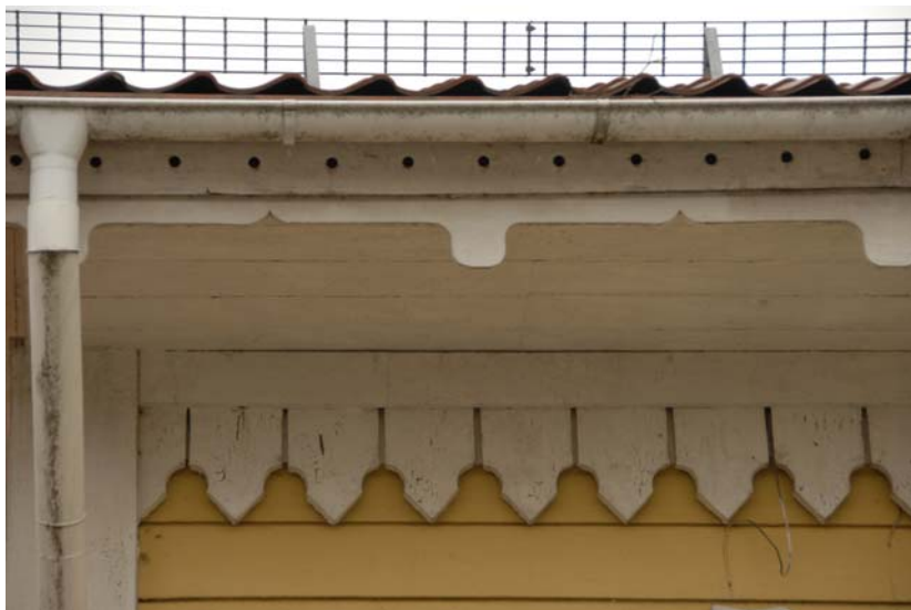
Figur 5. Tandsnittslist på fasad.
