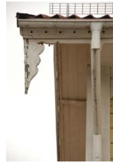
Figur 7. Droppliknande lövsågeriarbete.
