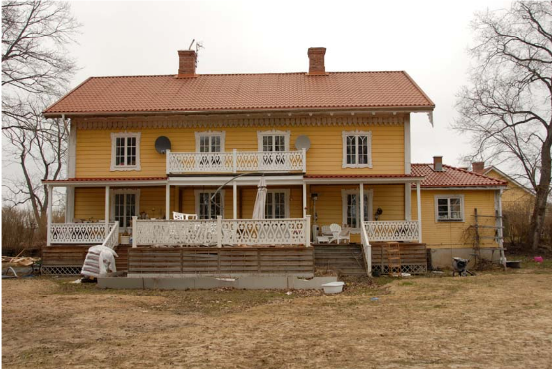
Figur 10. Senare tillkommet lövsågeriräcke på husets baksida.
