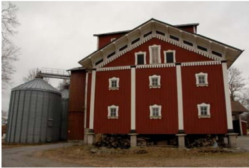
Figur 12. Fasad med pilastrar och tandsnittsbård.
