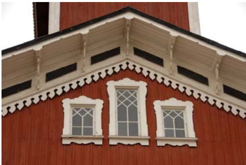
Figur 14. Detalj av krysställda spröjs.
