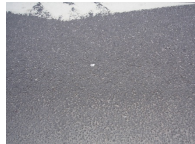
Figur 19. Bilväg med asfalt
