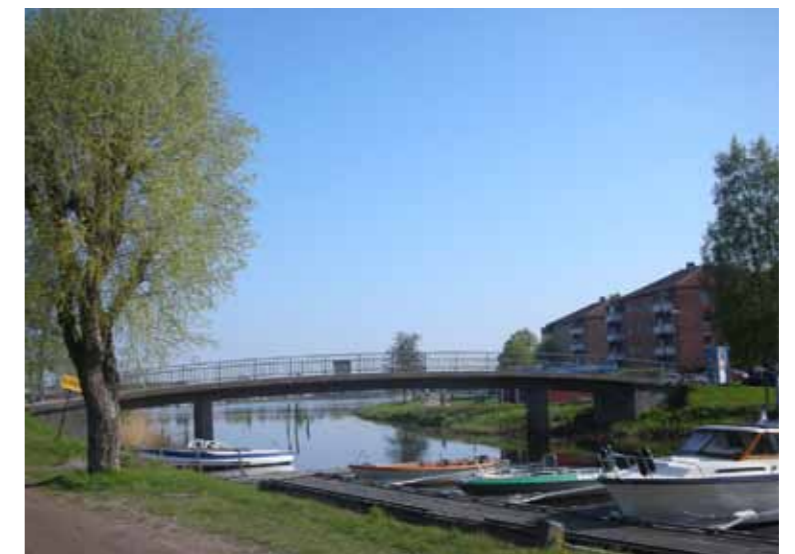
Bild 30: Gång- och cykelbron som går över Lambergskanalen. Bron är välvd vilket gör det svårt för rörelsehindrade personer att ta sig över.
