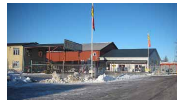
Bild 24: Området består till stor del av plåtbyggnader som har byggts om och på under åren.
