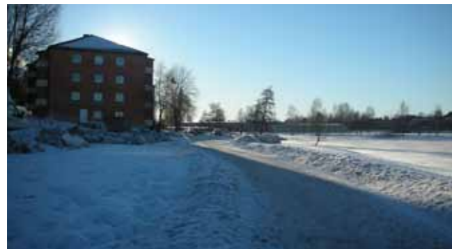
Bild 45: Byggnaderna kring tjärnen är monotona. Markförhållandena är även de monotona med flacka gräsbevuxna ytor. Den monotona känslan blir än mer påtaglig under vinter då även tjärnen är vit och platt som resten av omgivningen
