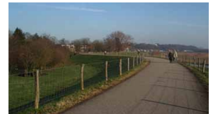
Bild 3: Bild från en vall i Holland som fungerar både som skydd mot vatten men även som en gång- och cykelväg.
