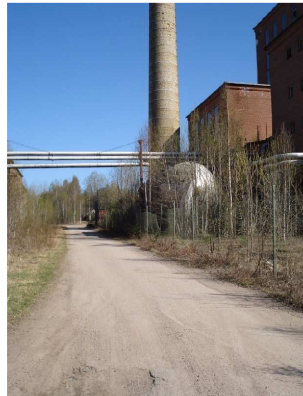
Figur 21. Rör och ledningar mellan fabriksbyggnader, (Foto: Elin Larsson 2011-04-29)
