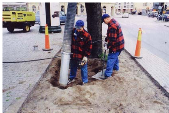
Figur 20. Bärlagret och den gamla kullerstensytan mellanträden sögs bort till ett djup av 60-70 cm (Dablin, Stig 2004).
