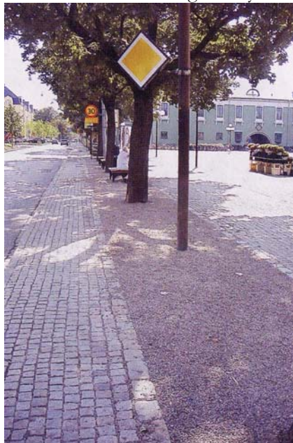
Figur 22. Nytt slitlager mellan träden, markraster, "Pelleplattan", fylld med bergkross 4/8 mm (Dahlin, Stig 2004).
