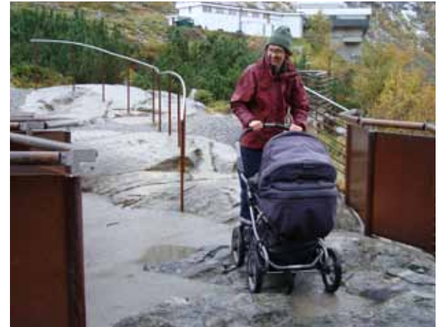
Betongen som fyller klippans största hål skapar tillgänglighet.
