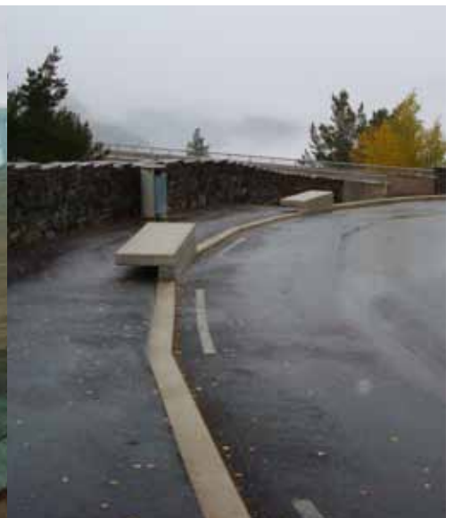
Betongkanten som skiljer gångyta från bilväg.
