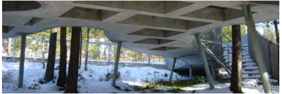
I betongens rutmönster ligger galler som ger genomsiktighet till markytan under.
