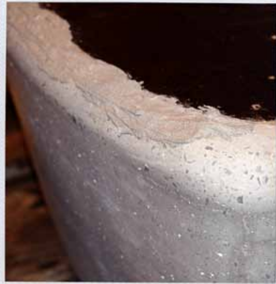
Spackling av trasiga betongkanter.
