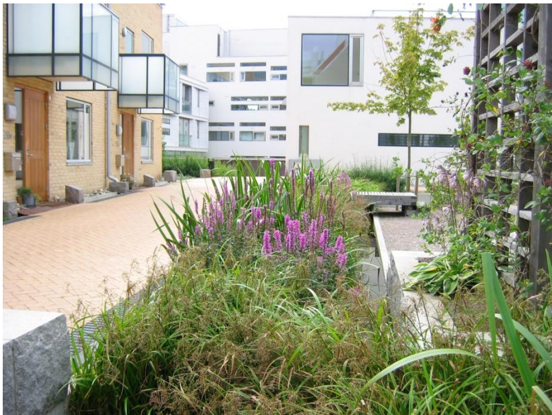
Figur 12. Ett öppet kanalsystem med dagvattenväxter i Västra hamnen, Malmö (Publicerad med tillstånd från Veg Tech).
