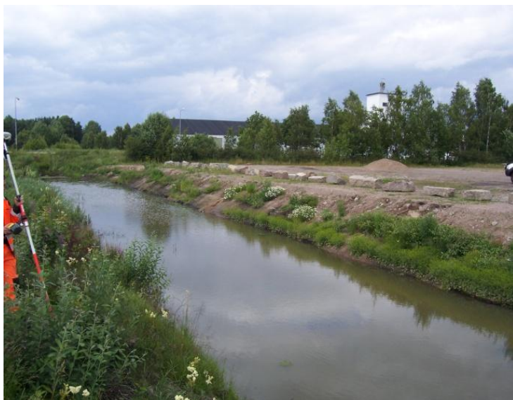
Figur 15. Vimmerbys dagvattendamm (Foto av: Larsson, Malin 2009).
