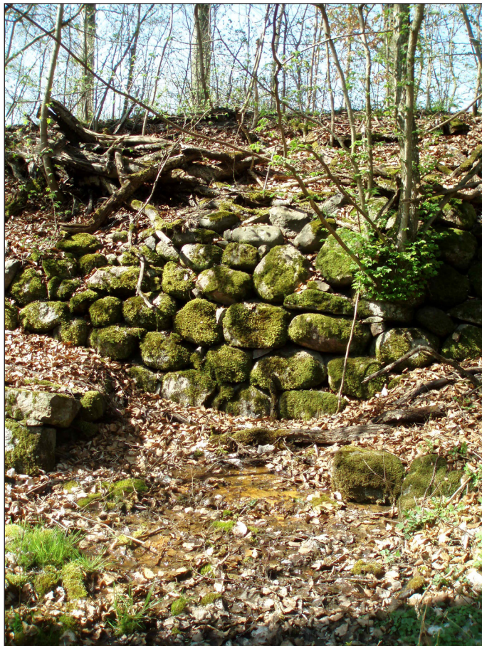
Figur 106. Slänten vid den gamla hälsokällan (120) har blivit uppmurad och framför den sipprar rostbrunt vatten upp.
