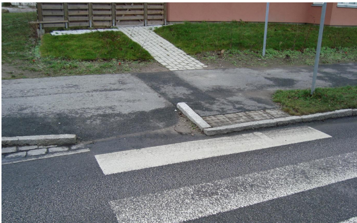
Figur 3. Lommavägen i Arlööv. Ett övergångsställe för både gång och cykel där cykelövergången är för smal för maskinellt underhåll. Foto: Rickard Andersson.
