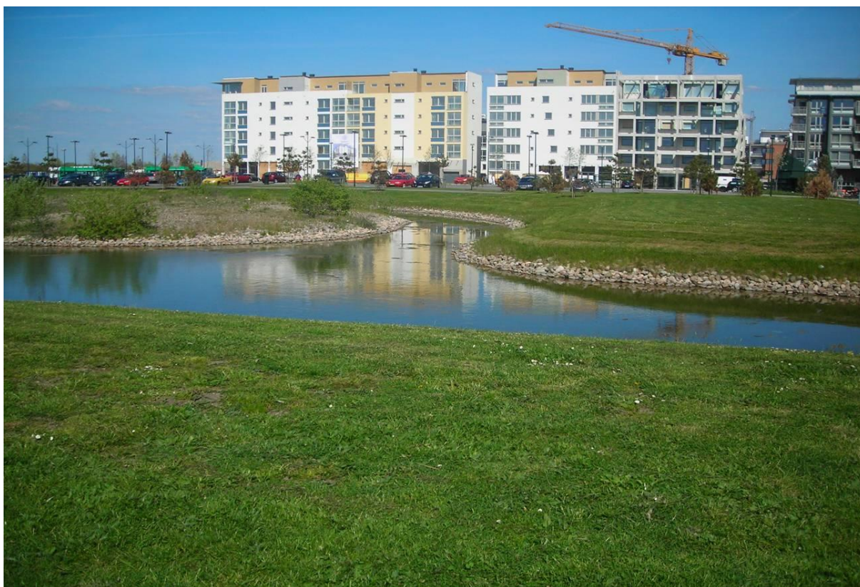
Figur 2. Västra hamnen i Malmö. Ett exempel där drift och underhåll har prioriterats lägre än gestaltningen. Kanterna är för branta för en åkgräsklippare att klippa närmast kanten. Foto: Erik Larsson.
