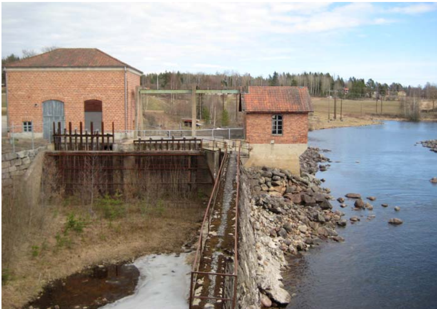
Landafors gamla kraftverk, i Ljusnan, tog inte kungsådran i anspråk. Det har det nya kraftverket i Landafors gjort.
