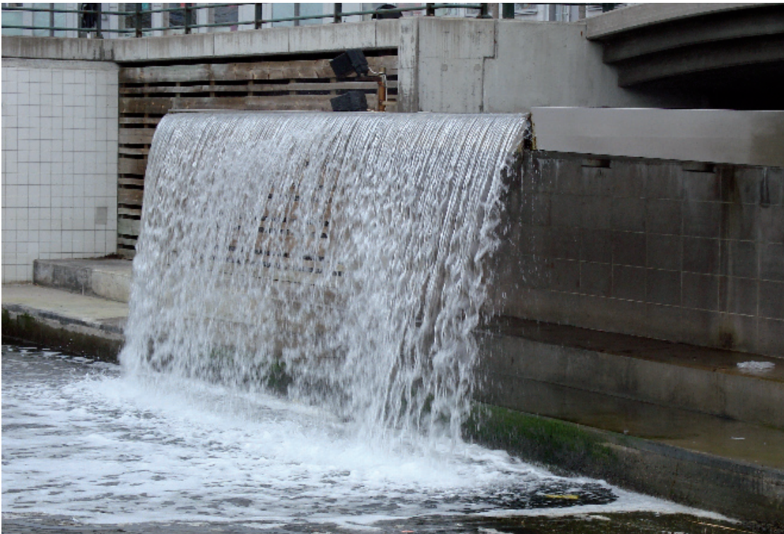
Figur 5. Vattenfall i områdets östra del som kopplar samman saltvattenkanalen med Öresund samt tar upp höjdskillnaden i området.
