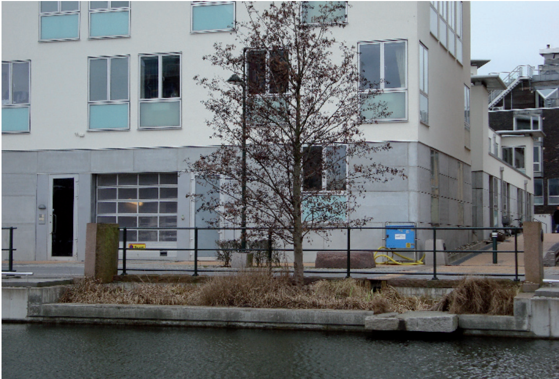
Figur 4. Uppsamlingsyta för dagvatten i anslutning till saltvattenkanalen. Planteringen innehåller ett bestånd av al och vattenvegetation.
