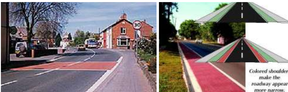
Figura 2-34 – Pavimentazione colorata (Department for Transport, 2000; Hallmark et al., 2007)
