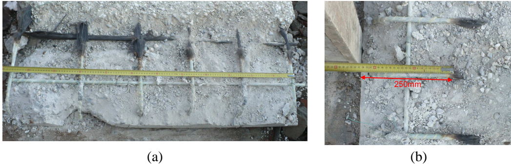
Figura 5.62 Verifica dello stato delle armature del Set III nella zona di ancoraggio: (a) estremità delle barre; (b) misurazione zona non eposta
