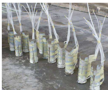
(a) dopo il getto del calcestruzzo
