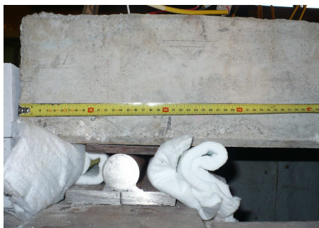
Figura 5.36 Particolare dell'appoggio dopo la disposizione del tessuto protettivo
