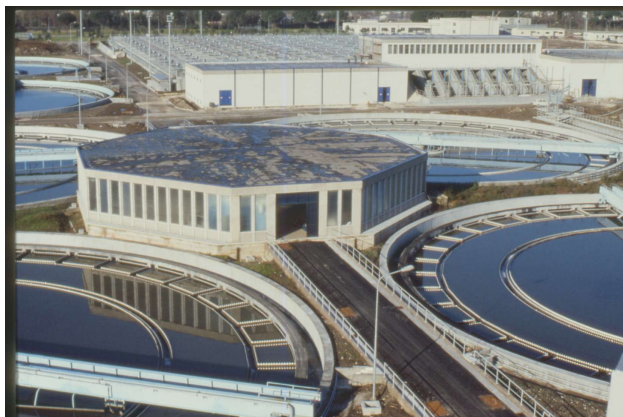
Fig. 8. Impianto di Depurazione di Cuma (Napoli-Ovest).
