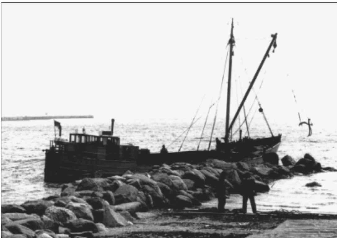
Abbildung 3: Steinzangerschiff „Erna“ beim Buhnenbau in Eckernförde, etwa Ende der 60er Jahre. (Alle Fotos aus dem Besitz von Karl-Heinz Weiss, Hamburg)
