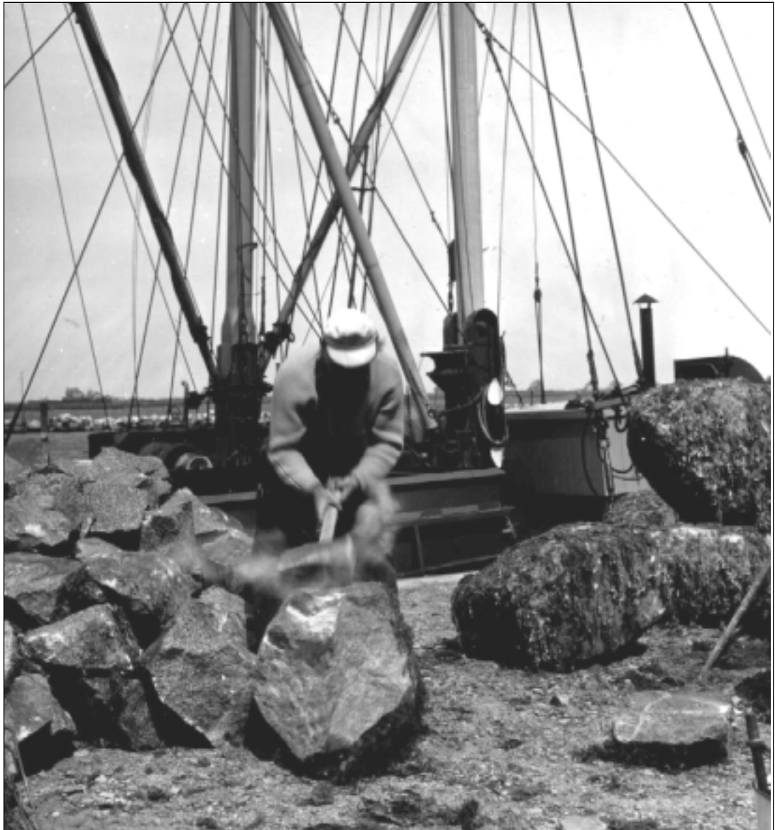
Abbildung 2: Steinschläger in Burgstaaken/Feh- marn spaltet mit 16 kg schwerem Ham- mer Findlinge, um 1960.
